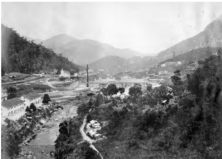
Figura 1 – Vista da Fábrica Petropolitana
