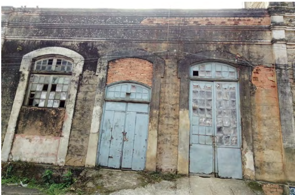
Figura 31 – Foto térrea detalhe da fachada norte
