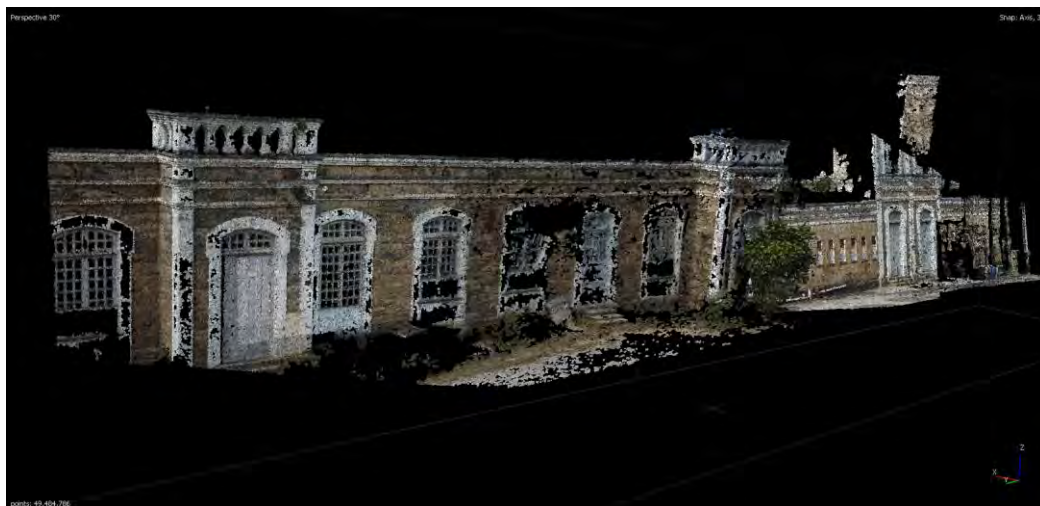
Figura 25 – Fachada escaneadas em nuvem de pontos
