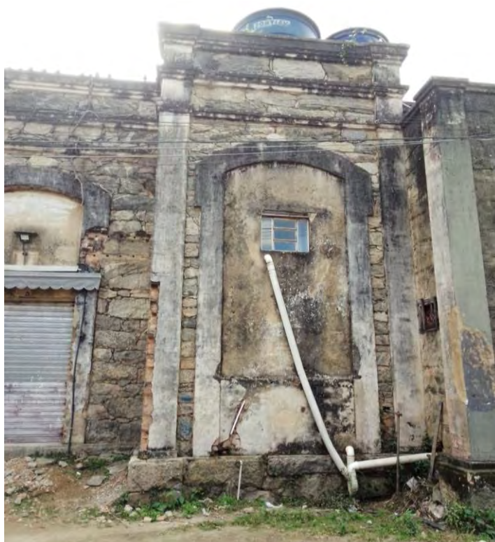
Figura 32 – Foto térrea detalhe da fachada norte
