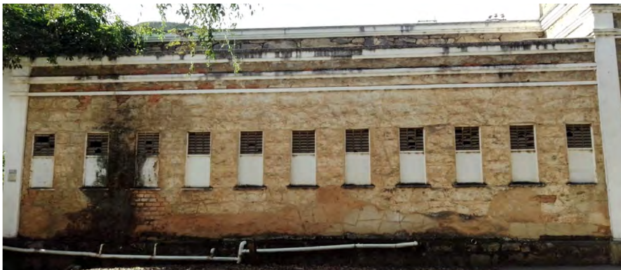
Figura 29 – Foto térrea detalhe da fachada oeste
