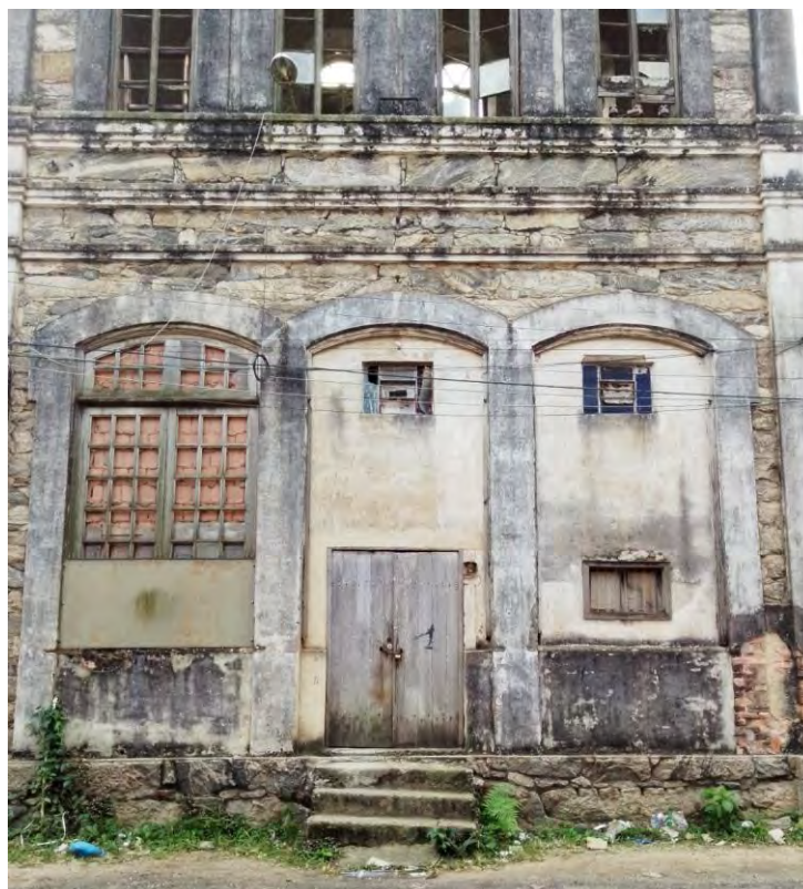
Figura 33 – Foto térrea detalhe da fachada norte Fonte: Maurilio Pimenta / Mariana Lima
