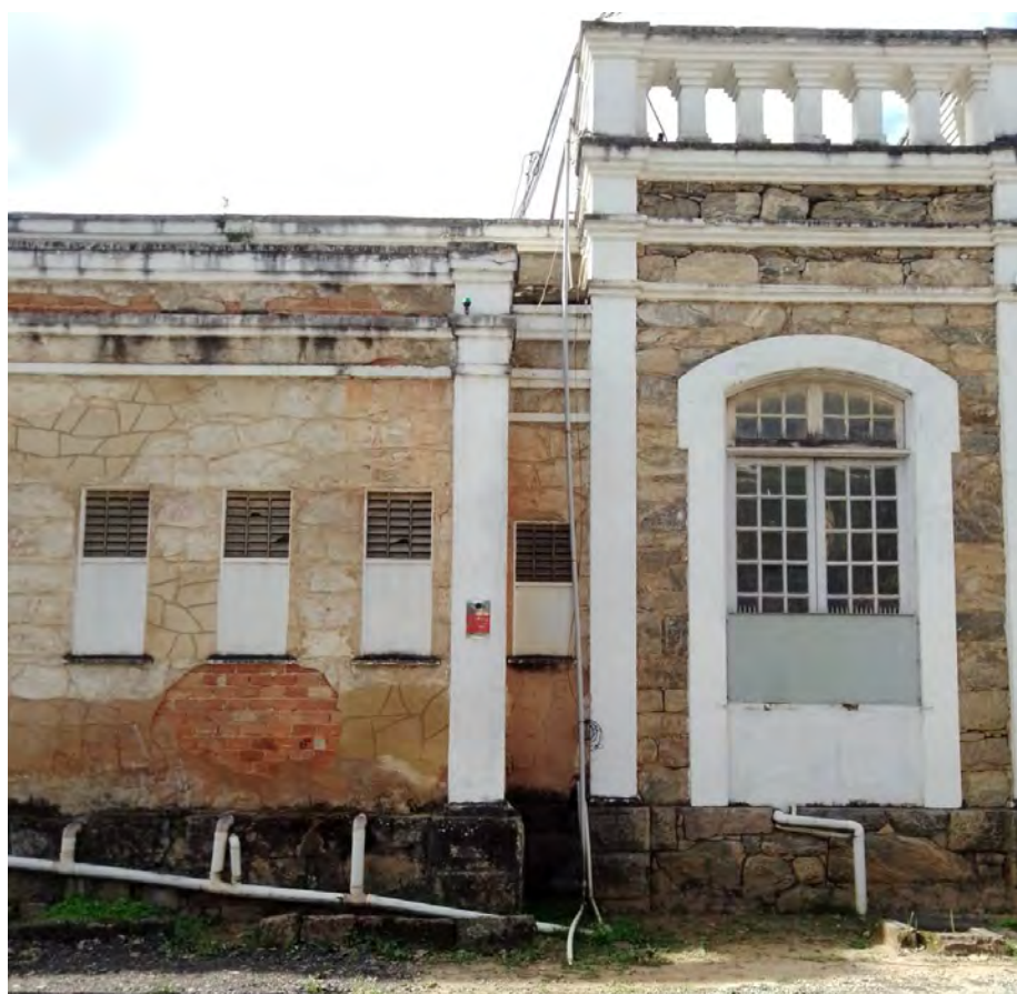
Figura 30 – Foto térrea detalhe da fachada oeste
